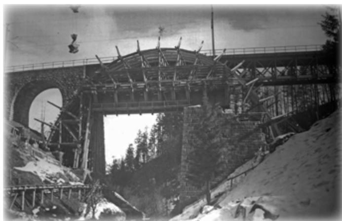
*Die erste Brücke über den Moosbach hatte ausgedient. Um 1930 errichtete man jene Eisenbetonbrücke mit dem Hauptbogenradius von 37,5 Metern, damals die größte ihrer Art in Österreich. Auch der Firstbaum in der Mitte des Bogens ist zu erkennen. 2023 wird sie mit großem Aufwand generalsaniert.*
